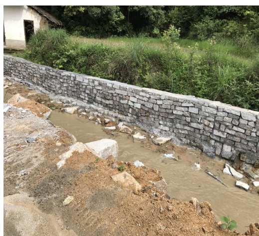
施工生产生活区临时排水沟
