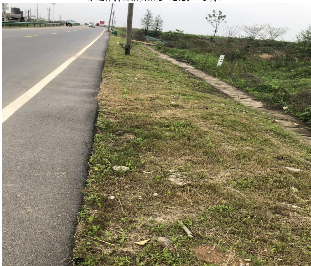
水土保持措施实施后（2020 年 3 月）
