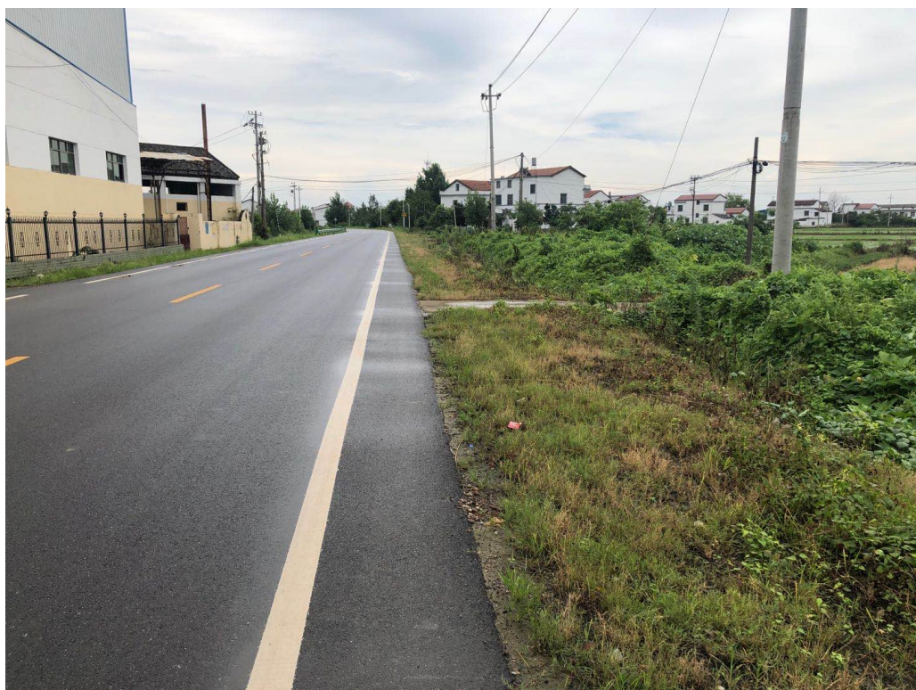
水土保持措施实施后（2021 年 3 月）
