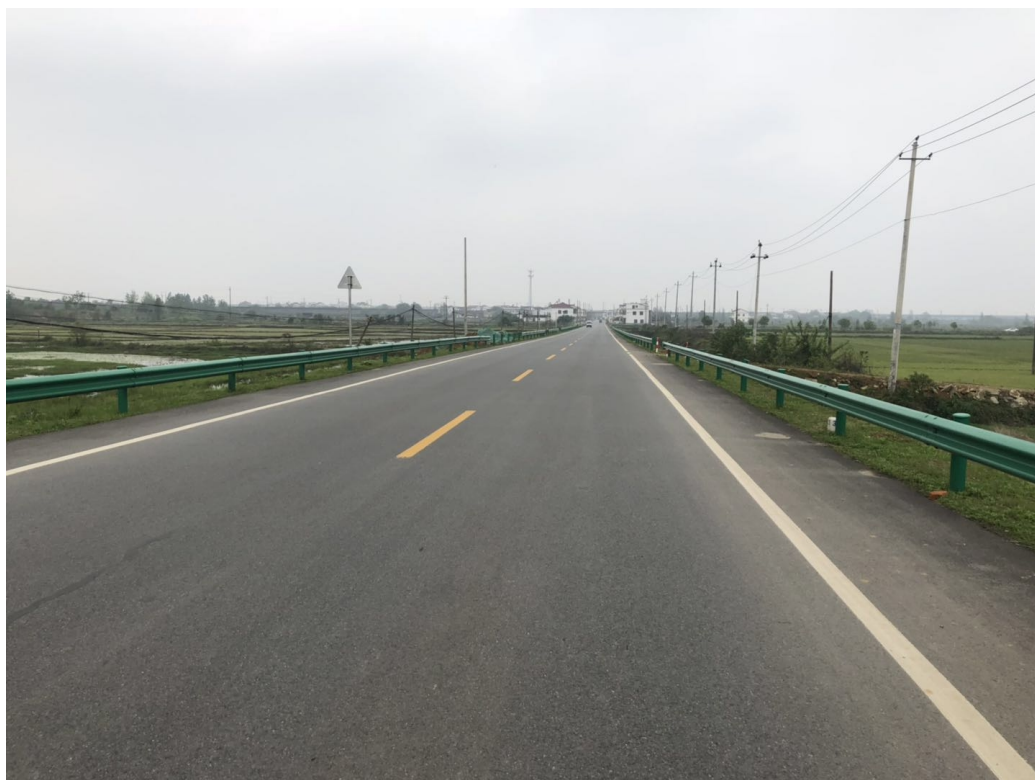
水土保持措施实施后（2020 年 12 月）
