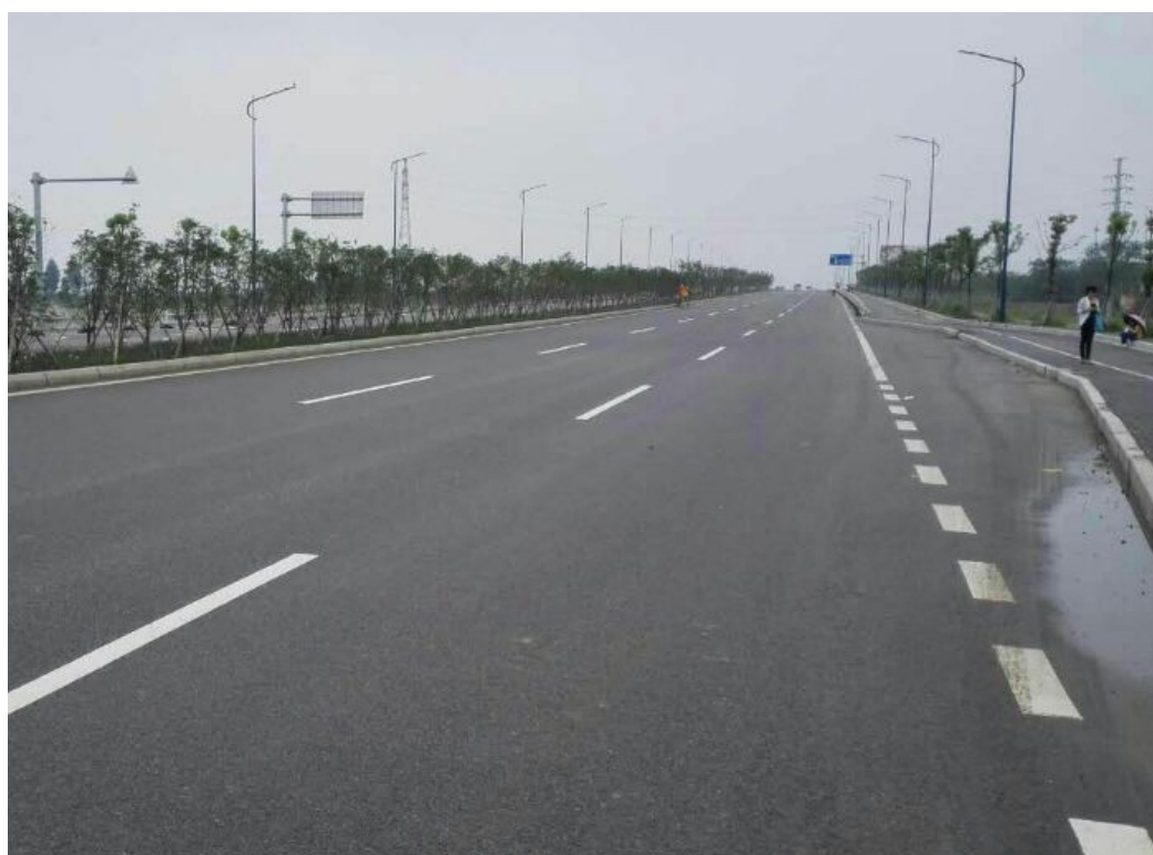
水土保持措施实施后（2020 年 12 月）
