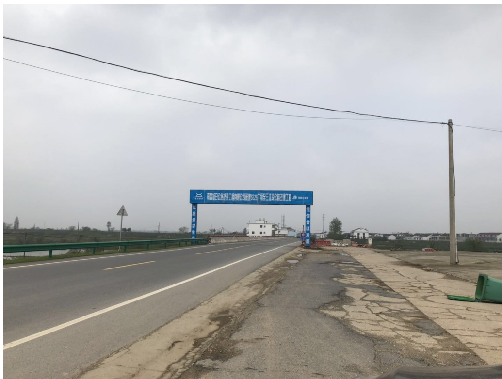
水土保持措施实施后（2020 年 3 月）
