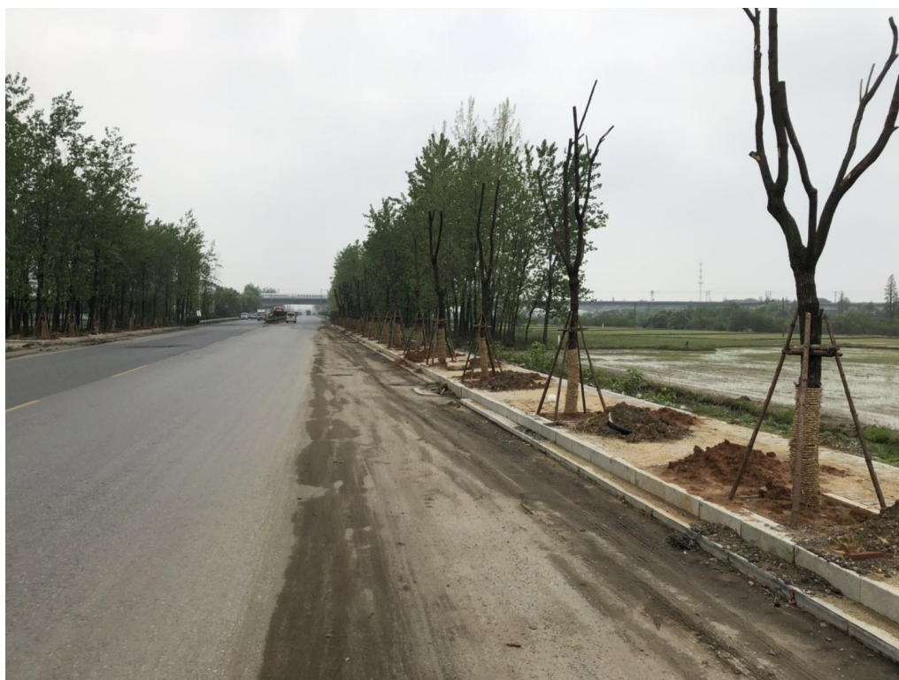
水土保持措施实施后（2020 年 3 月）
