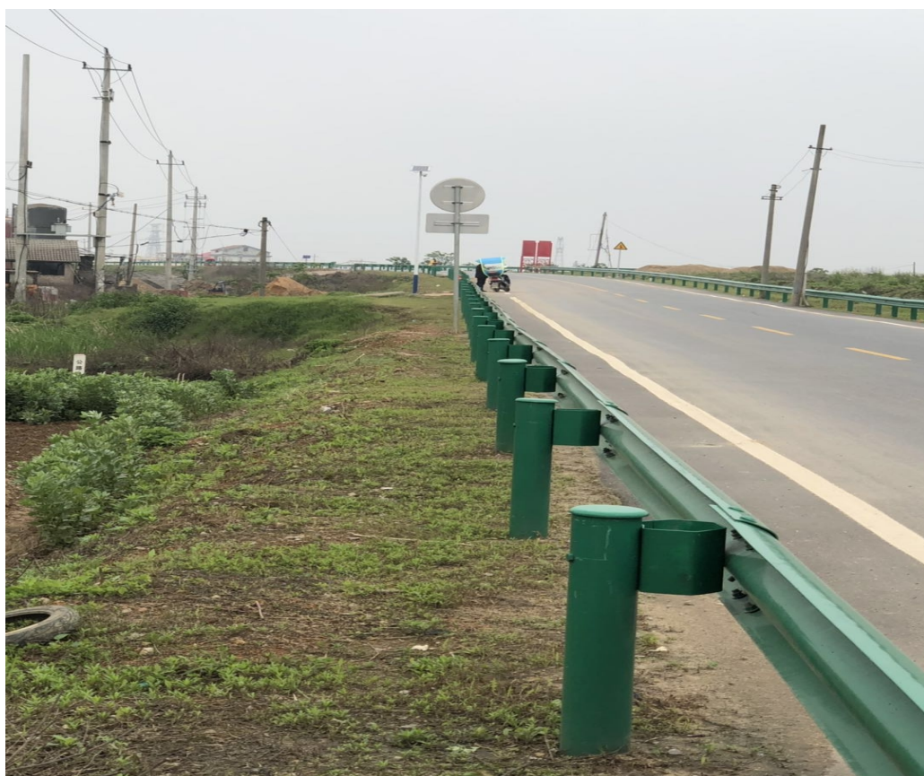
水土保持措施实施后（2020 年 3 月）
