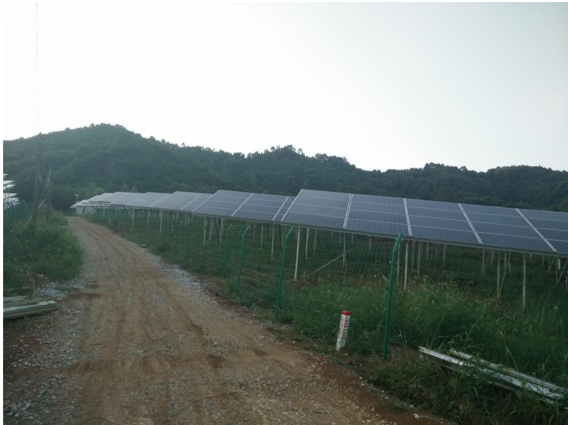
项目区内泥结石道路
