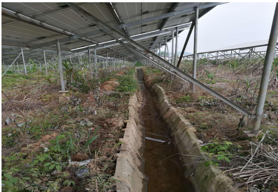
生产区内 U 形槽排水沟
