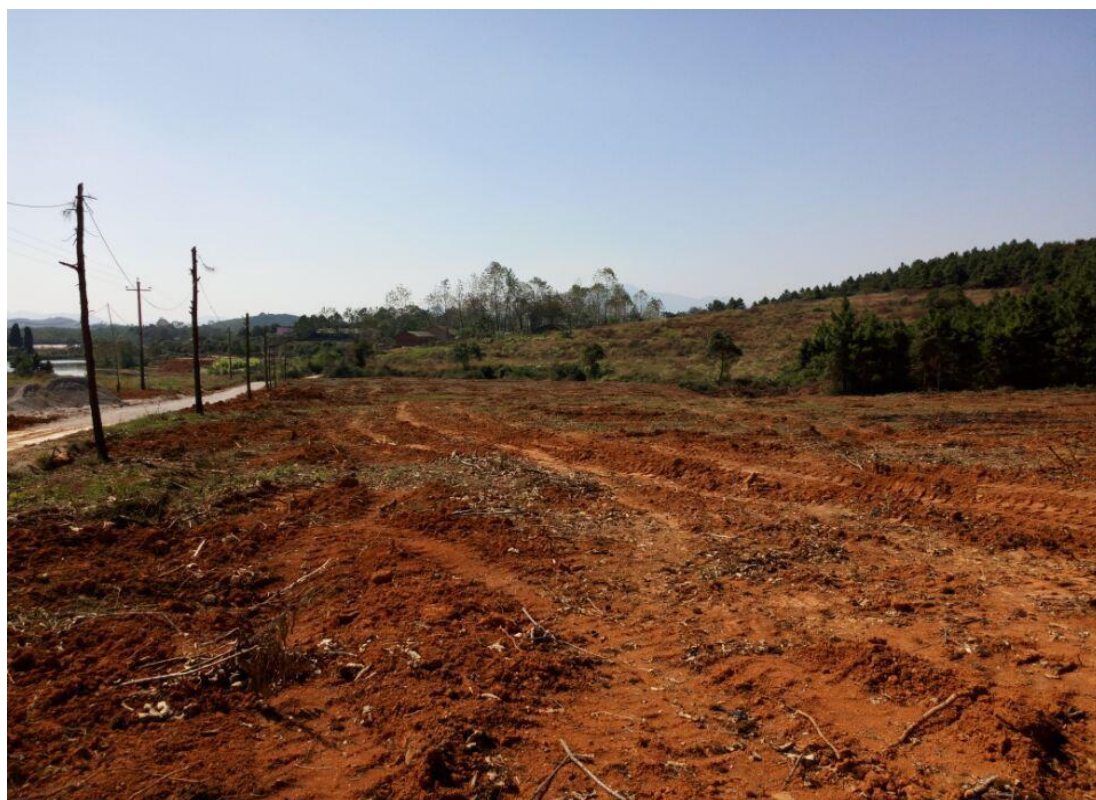
施工期项目区内场地平整
