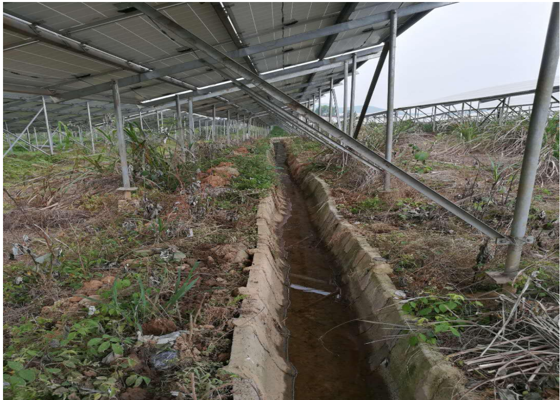
光伏阵列区 U 型槽排水沟
