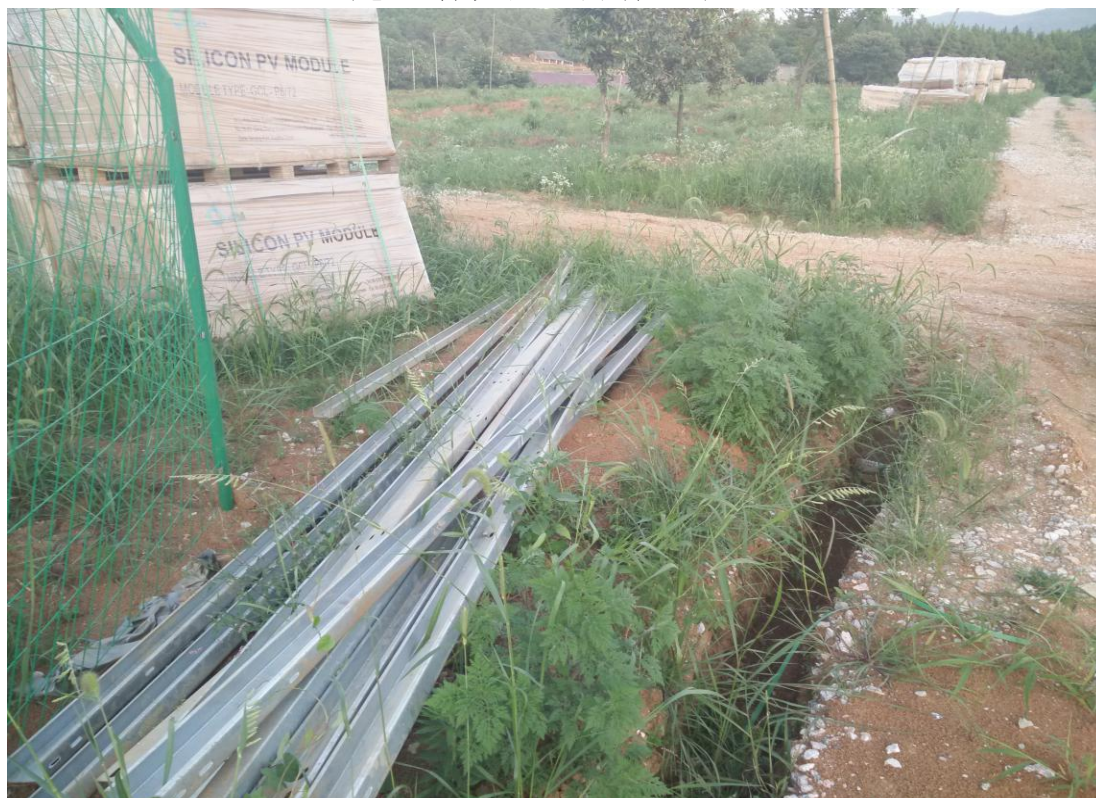
道路两侧土质排水沟
