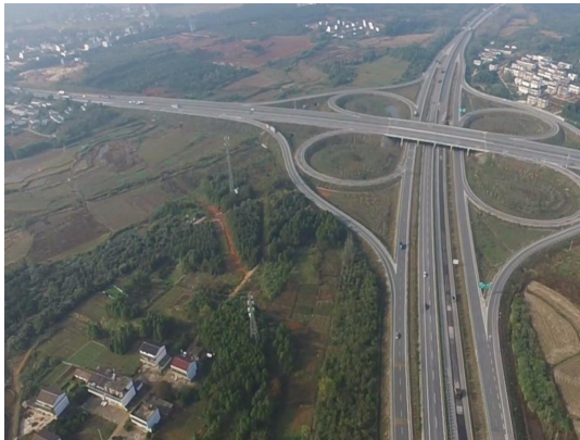
项目终点现状
