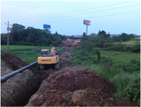
管沟开挖施工
