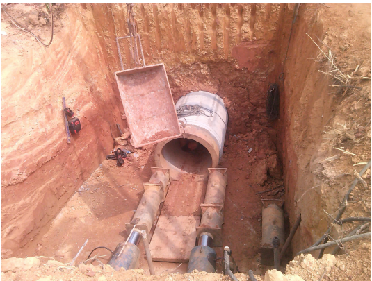
管道跨穿越施工
