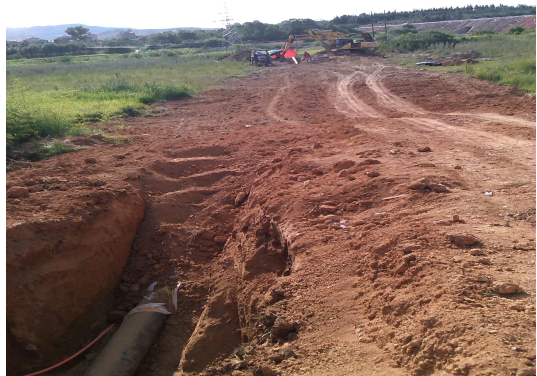
管沟回填施工
