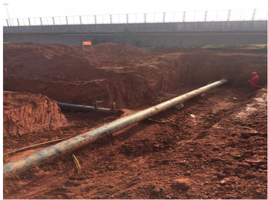
管沟开挖施工
