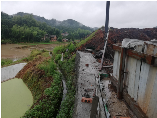
浆砌石挡土墙
