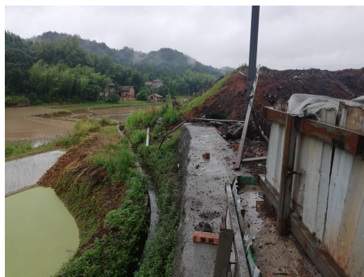
浆砌石挡土墙
