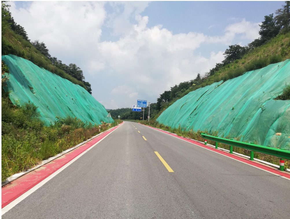
路基工程区两侧绿化及临时覆盖
