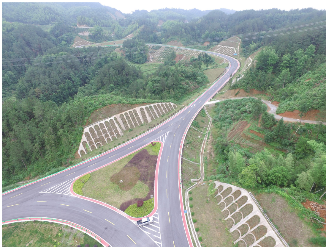
道路边坡综合骨架护坡
