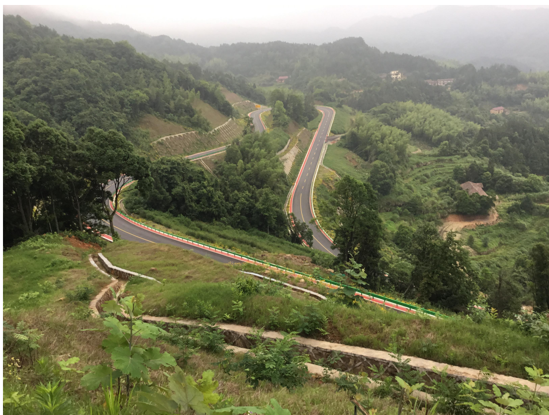
浆砌石截水沟
