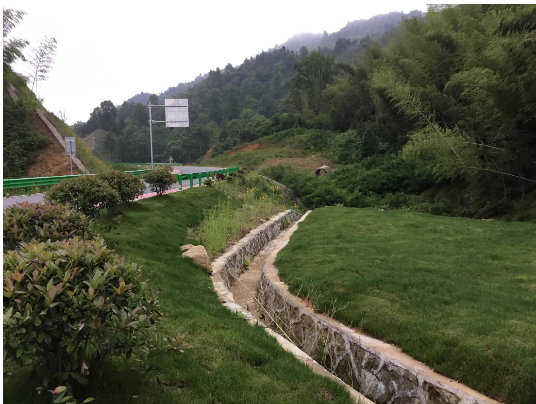
浆砌石排水沟
