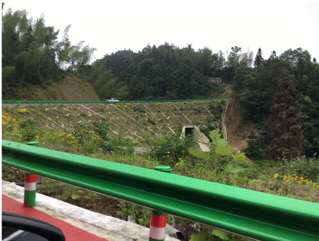
桥涵工程区植被恢复
