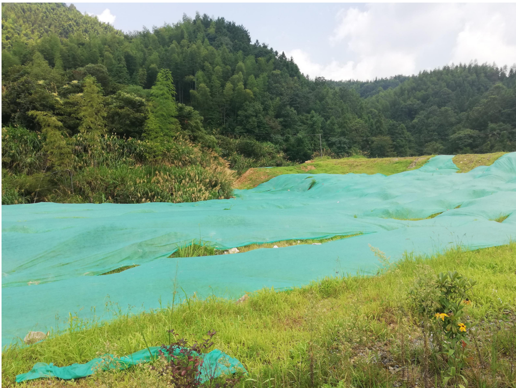
临时堆土区单侧绿化及临时覆盖
