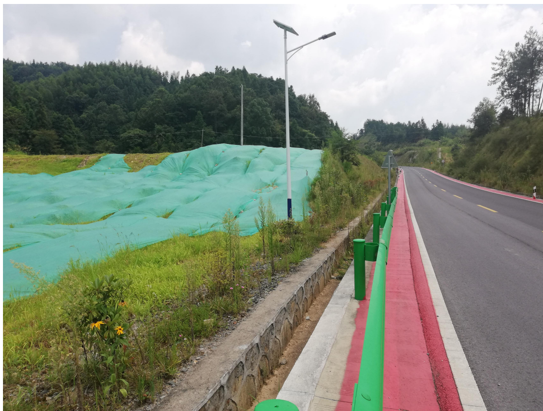
路基工程区浆砌石排水沟
