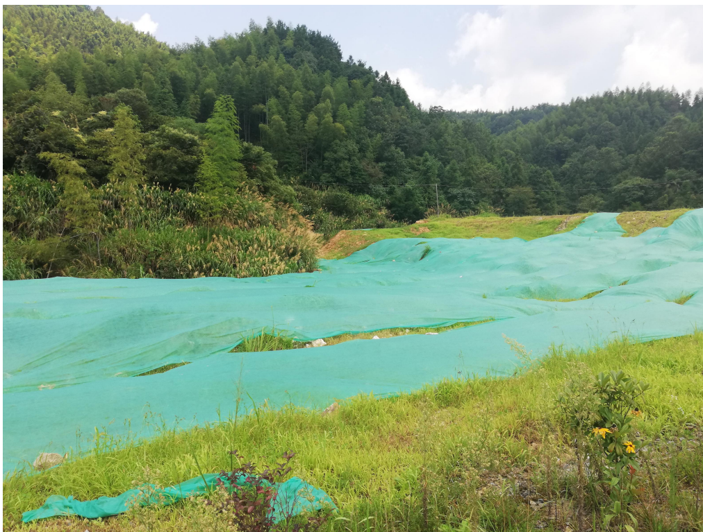
临时堆土区单侧绿化及临时覆盖
