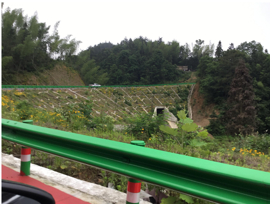
桥涵工程区植被恢复
