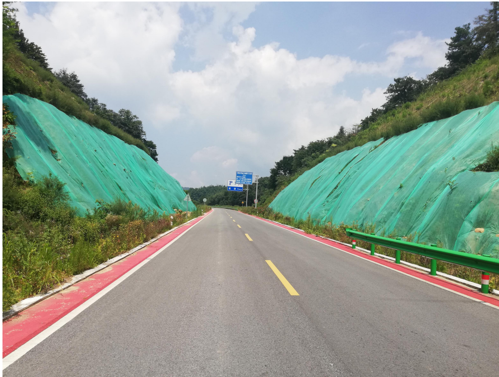
路基工程区两侧绿化及临时覆盖
