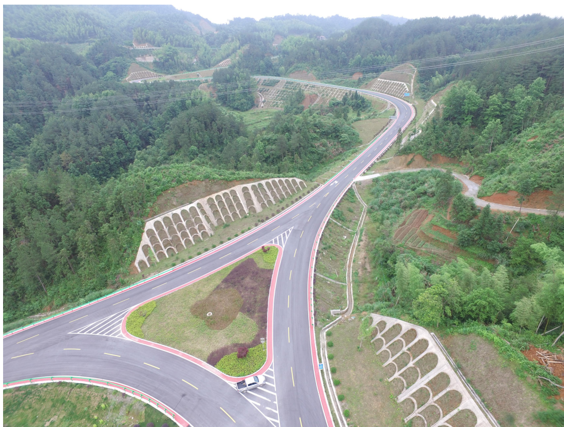
道路边坡综合骨架护坡
