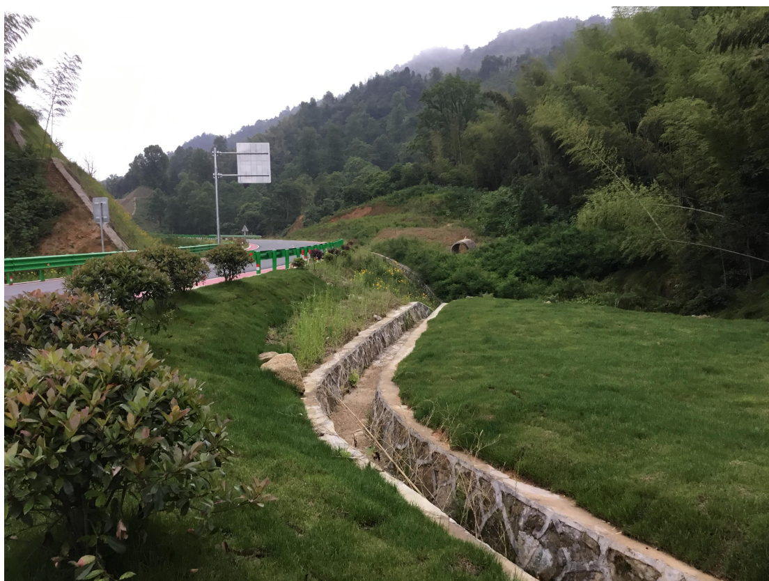
浆砌石排水沟
