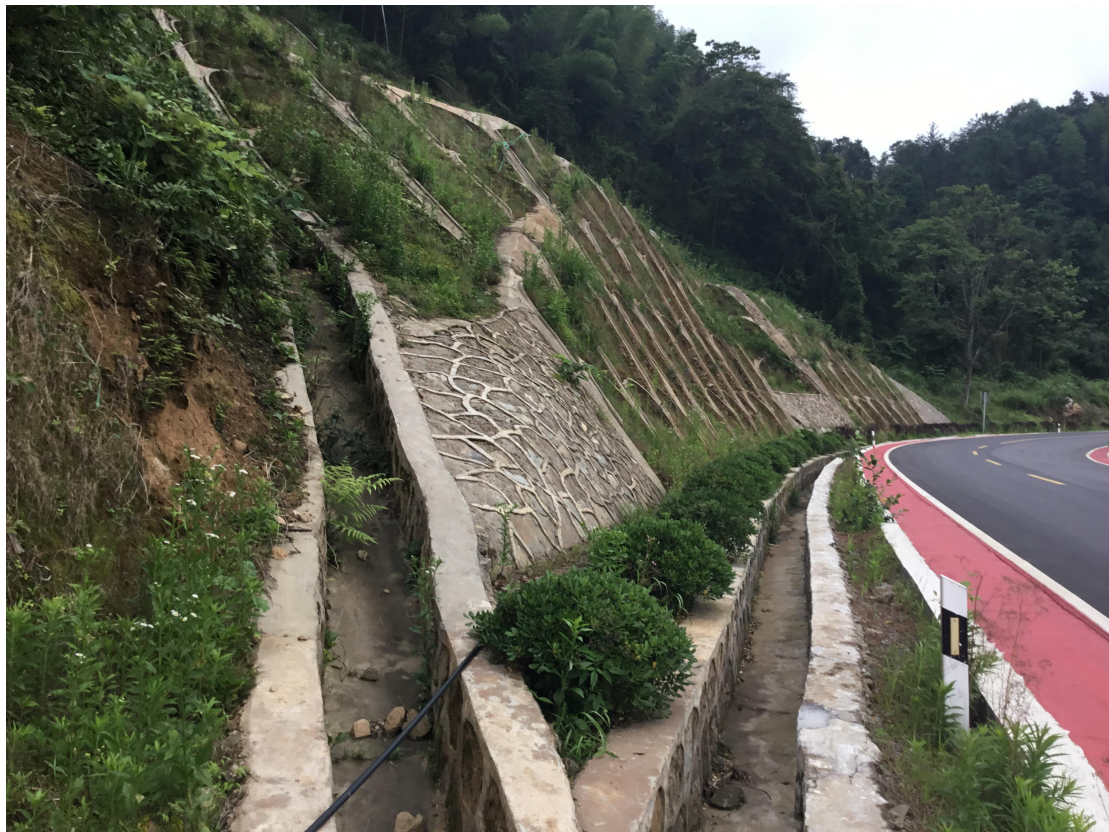
浆砌石截、排水沟
