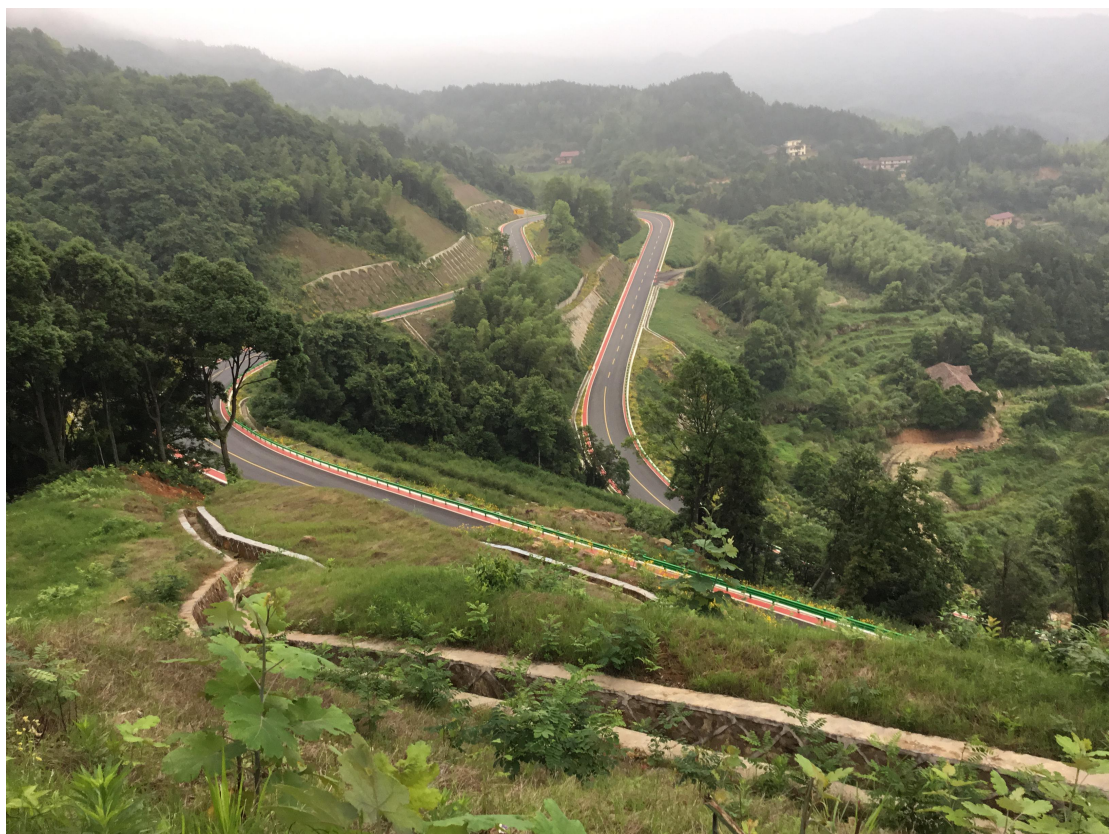
浆砌石截水沟
