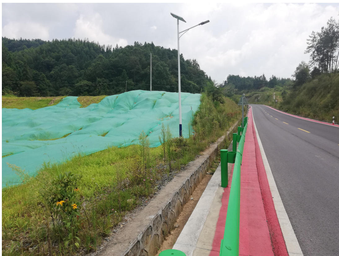
路基工程区浆砌石排水沟
