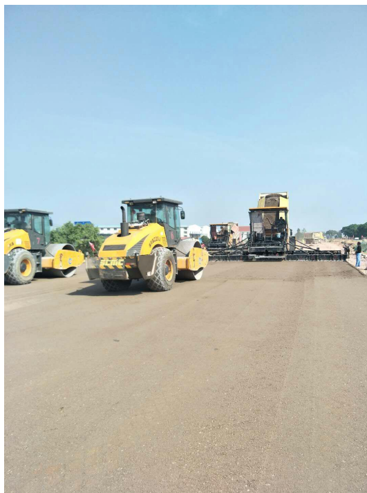
主体工程区路基基础施工
