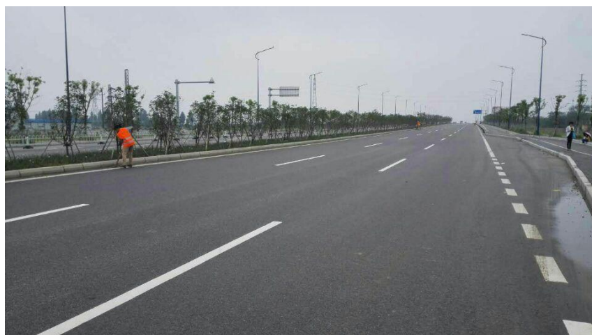
主体工程区路侧沿线绿化
