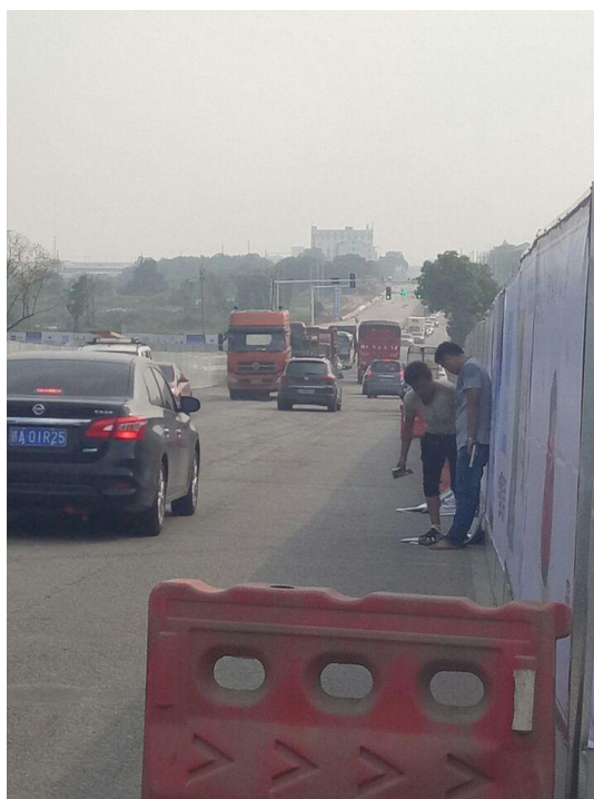
主体工程区沿线临时拦挡
