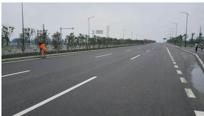
主体工程区路侧沿线绿化
