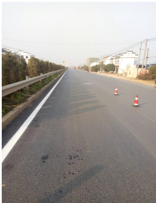
主体工程区路侧沿线绿化
