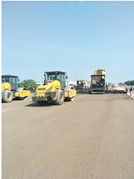
主体工程区路基基础施工
