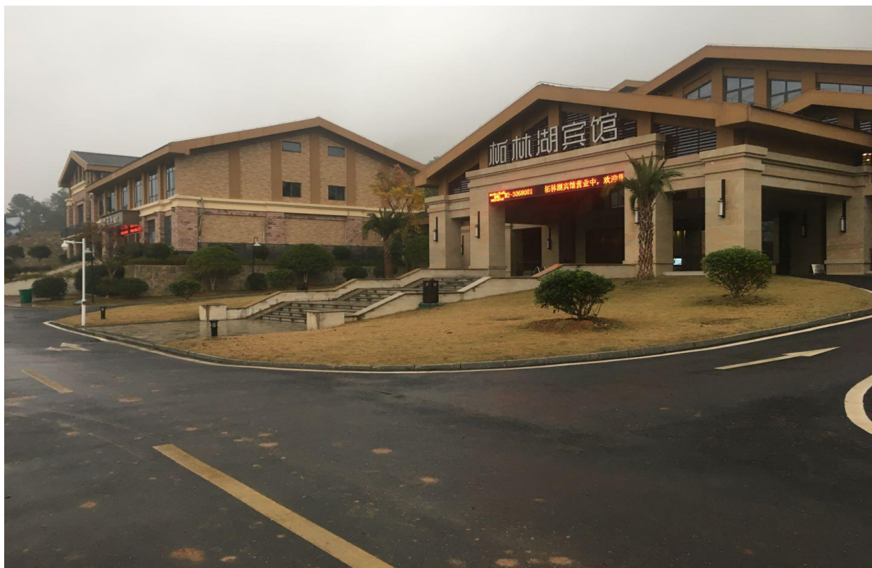
附图 1 项目区现场图片
