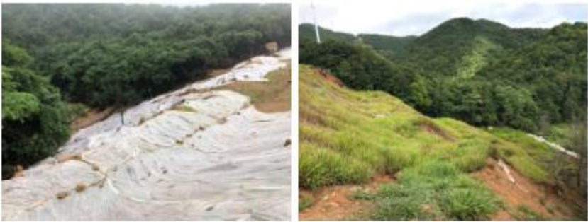
图 3-5 7#弃土场表面现场照
