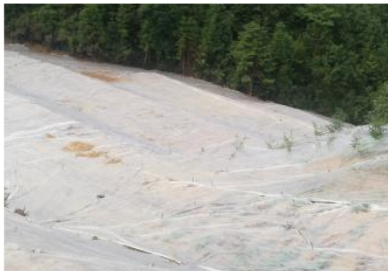
图1.3-3 弃渣场区绿化
