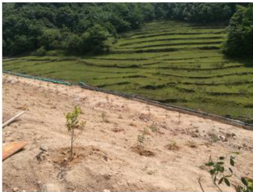
图1.2-3 升压站填方区分层
