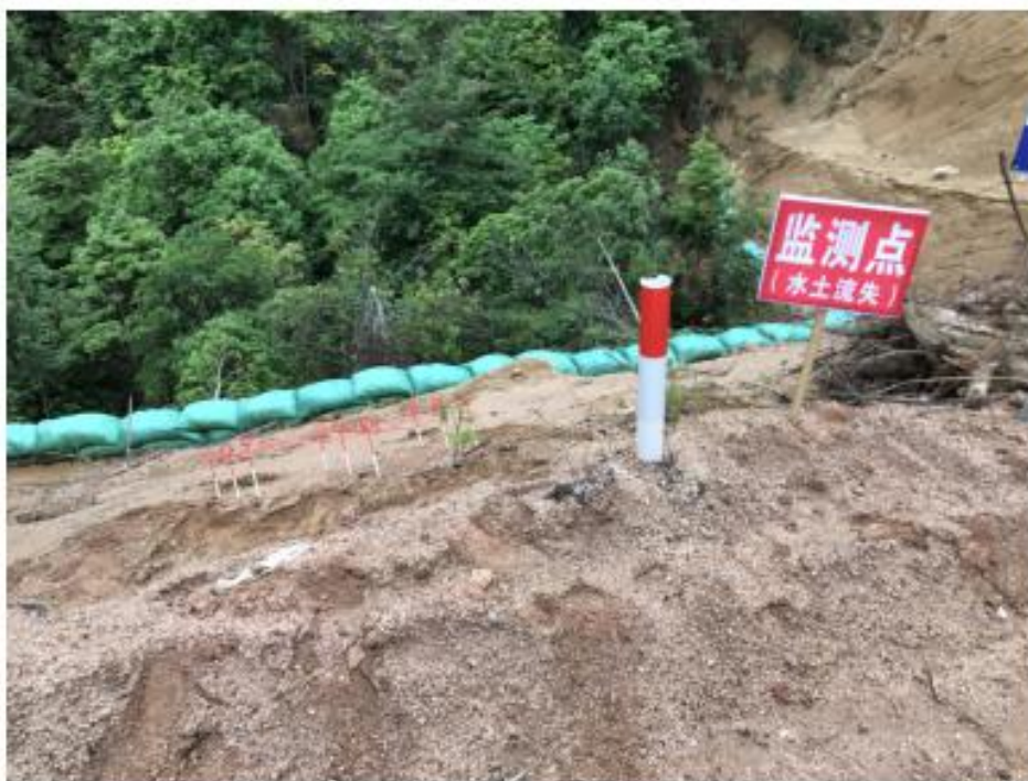
简易水土流失观测小区
