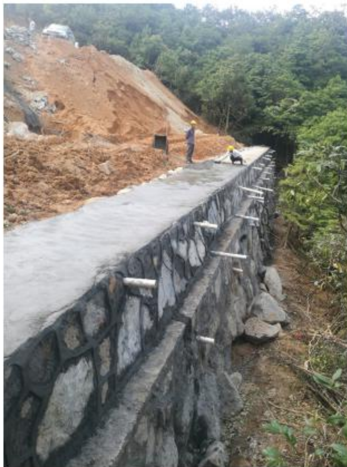
图1.1-4 填方区下部挡墙支护
