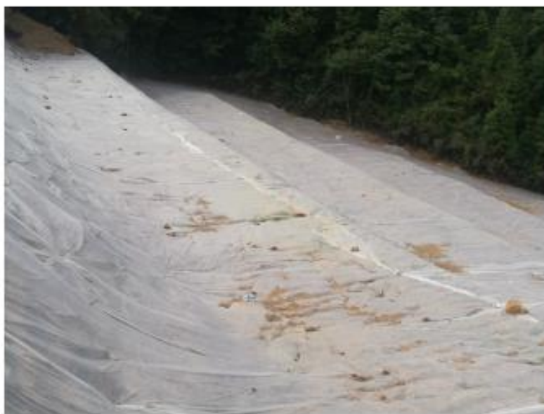
图1.2-2 弃渣场填方区分层
