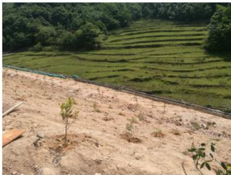
图1.2-3 升压站填方区分层
