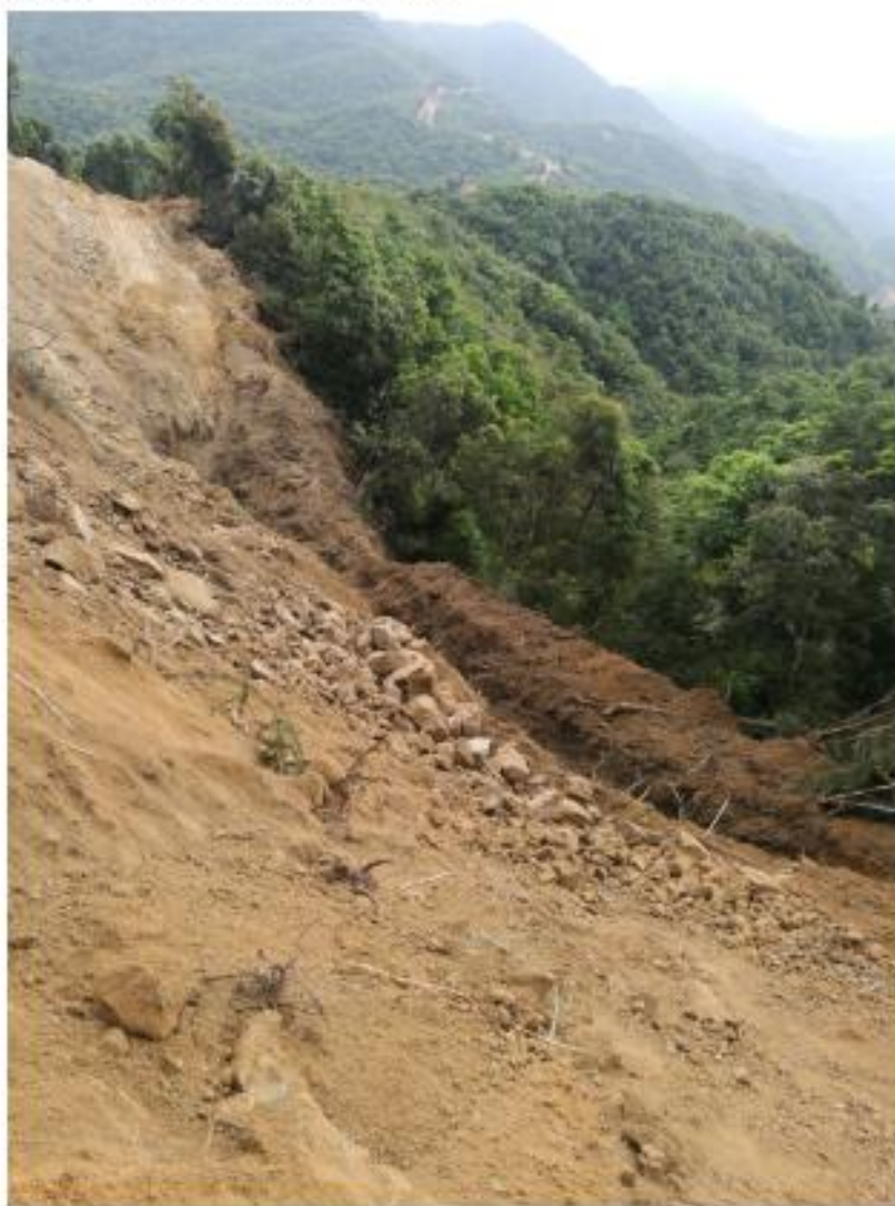
图1.1-1 填方区下部开设沟槽
