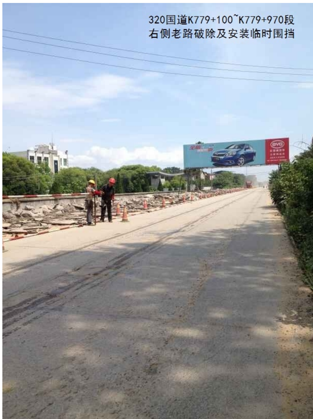
G320 国道老路破除及安装临时围挡
