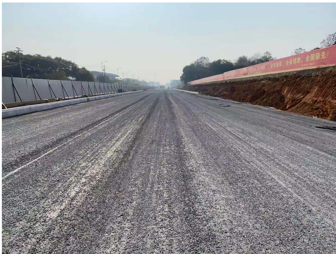
水土保持措施实施后（2020 年 11 月）
