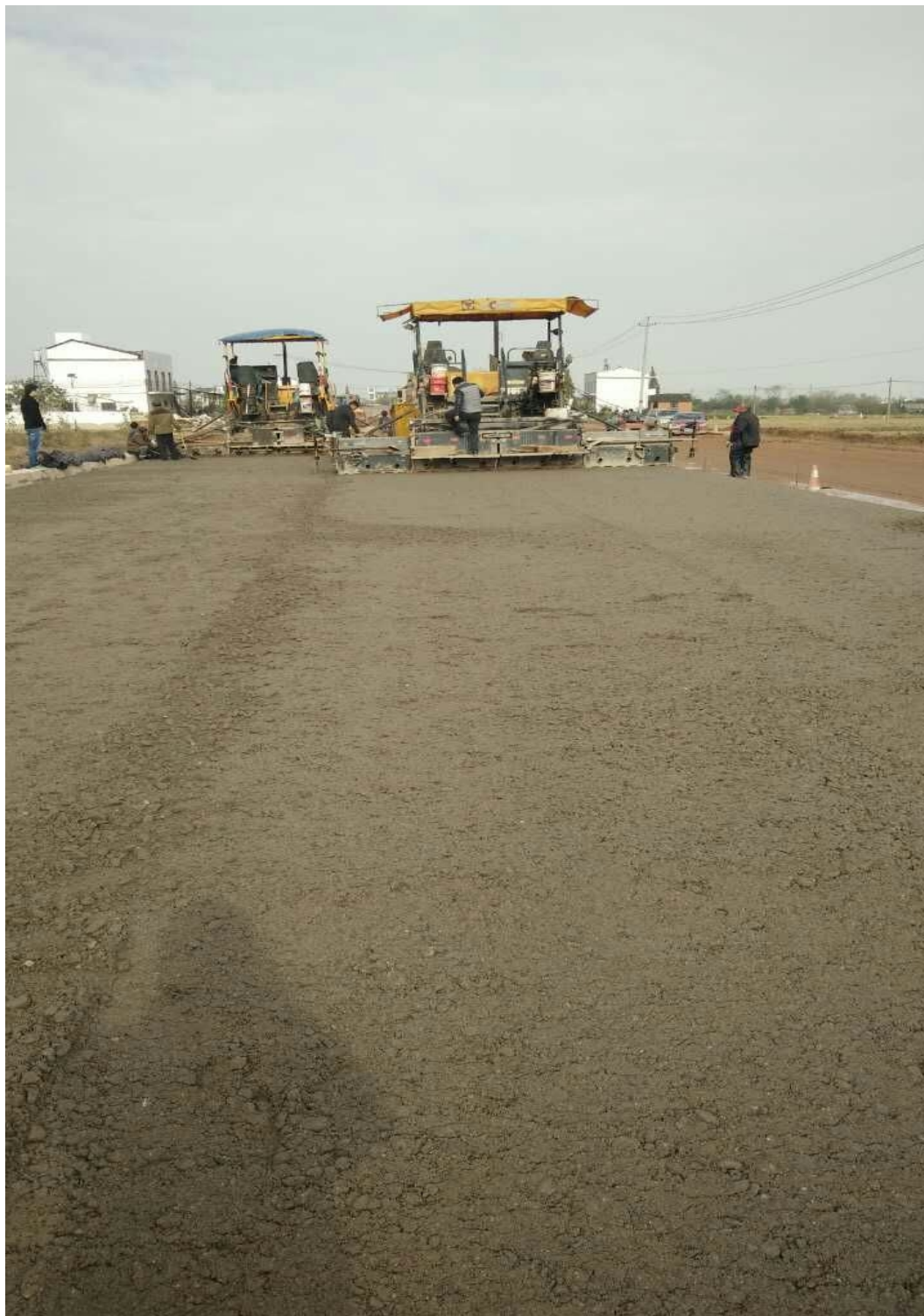
水稳摊铺（2016 年 7 月）
