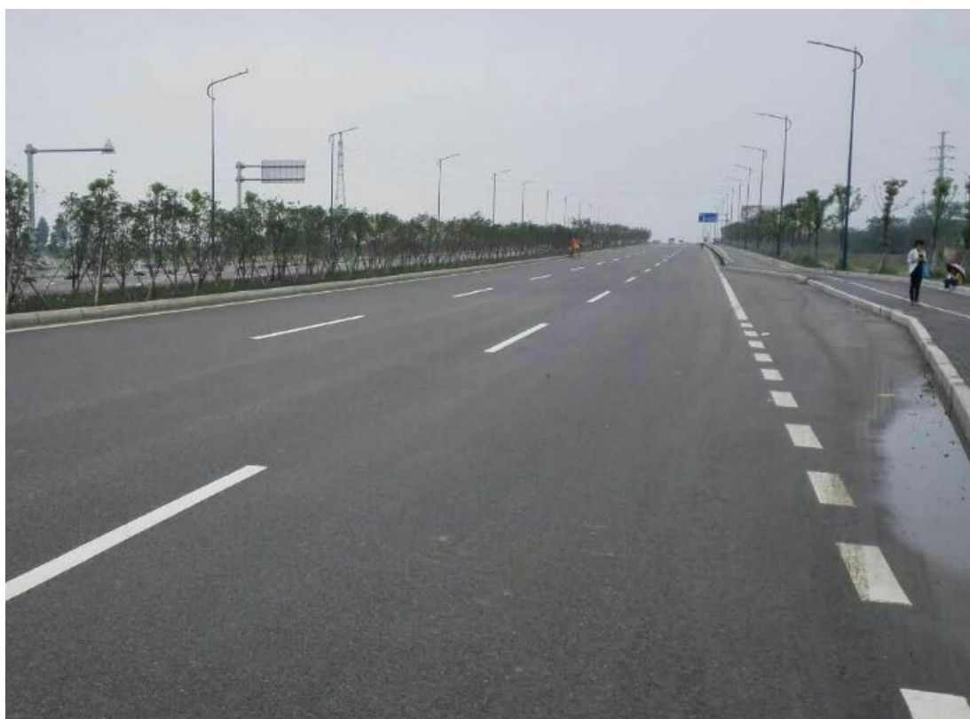
水土保持措施实施后（2021 年 3 月）
