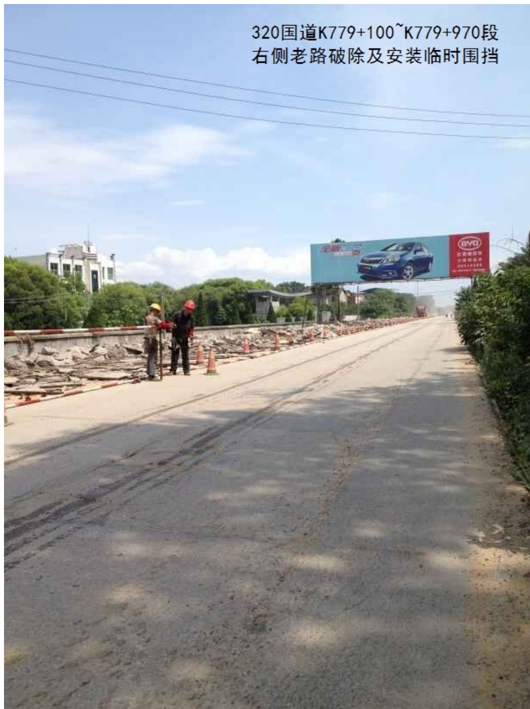
G320 国道老路破除及安装临时围挡（2015 年 6 月）
